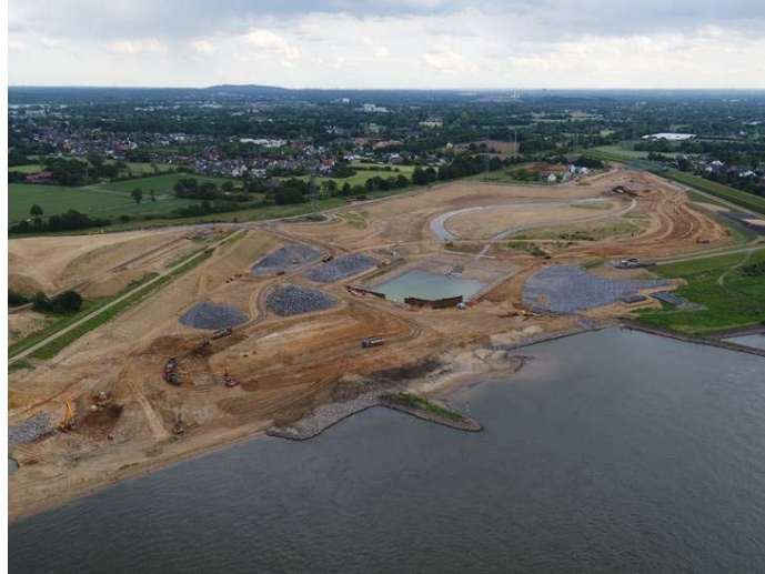
Mit neuen Gewässerläufen und für den zeitnah anstehenden Rheindurchstich vorbereitete Emschermündung (©Emschergenossenschaft 2022 – Jörg Saborowski)
